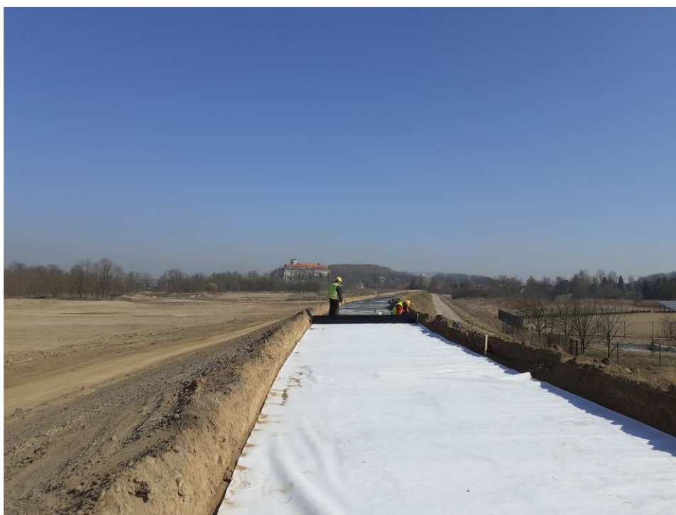
Foto. 37. Budowa drogi na koronie wału przeciwpowodziowego na Zadaniu 2, stan w trzeciej dekadzie marca 2022 r. (widok w dół rzeki).
