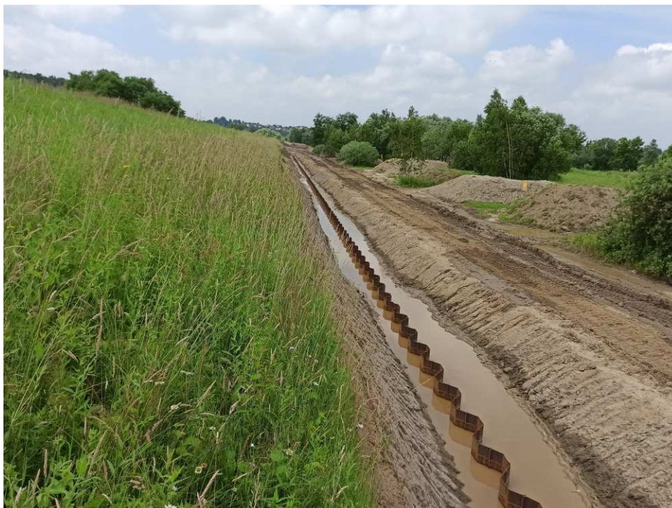
Foto. 28. Budowa przesłony ze ścianki szczelnej na Zadaniu 3, stan w trzeciej dekadzie czerwca 2020 r. (widok w górę rzeki).
