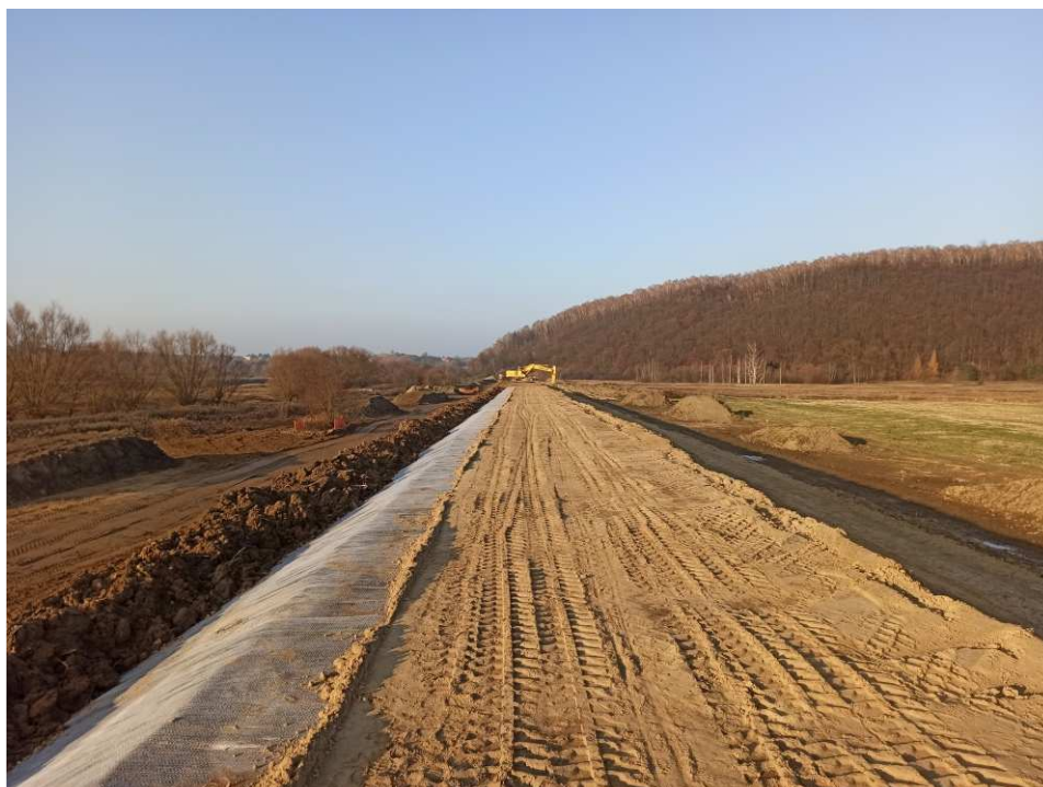
Foto. 34. Układanie bentomaty na skarpie wału przeciwpowodziowego na Zadaniu 1, stan w trzeciej dekadzie listopada 2020 r. (widok w dół rzeki).
