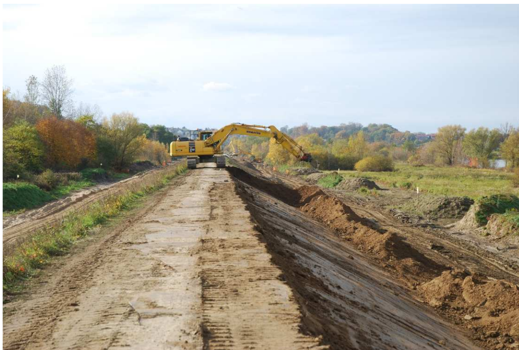
Foto. 32. Formowanie skarp wału przeciwpowodziowego na Zadaniu 3, stan w trzeciej dekadzie września 2020 r. (widok w górę rzeki).
