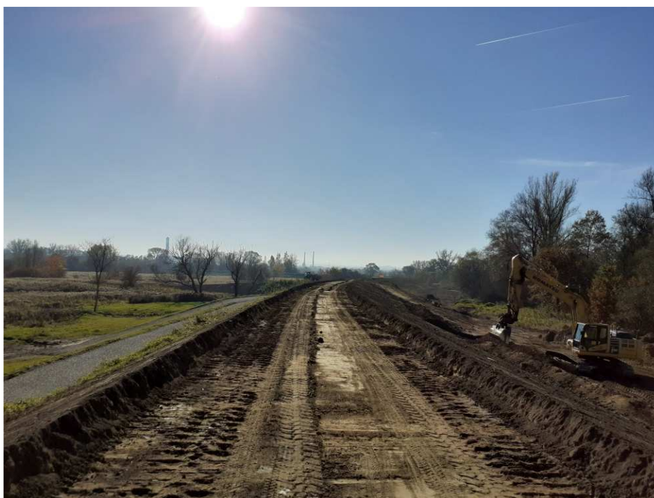
Foto. 35. Humusowanie skarp wału przeciwpowodziowego na Zadaniu 1, stan w trzeciej dekadzie października 2021 r. (widok w górę rzeki).
