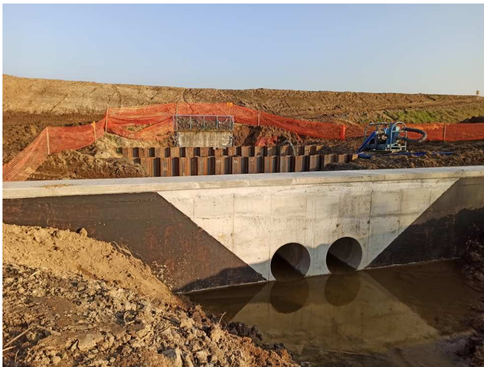
Foto. 25. Przebudowa przepustu wałowego w km 61+239 wału Wisły na Zadaniu 1, stan w trzeciej dekadzie listopada 2020 r. (widok od strony międzywału).
