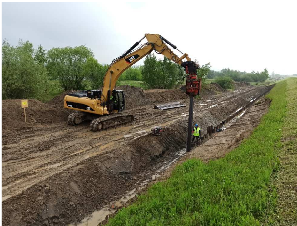
Foto. 27. Budowa przesłony ze ścianki szczelnej na Zadaniu 3, stan w trzeciej dekadzie maja 2020 r. (widok w dół rzeki).
