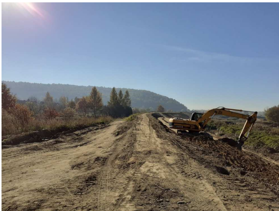
Foto. 36. Humusowanie skarp wału przeciwpowodziowego na Zadaniu 2, stan w trzeciej dekadzie października 2021 r. (widok w górę rzeki).
