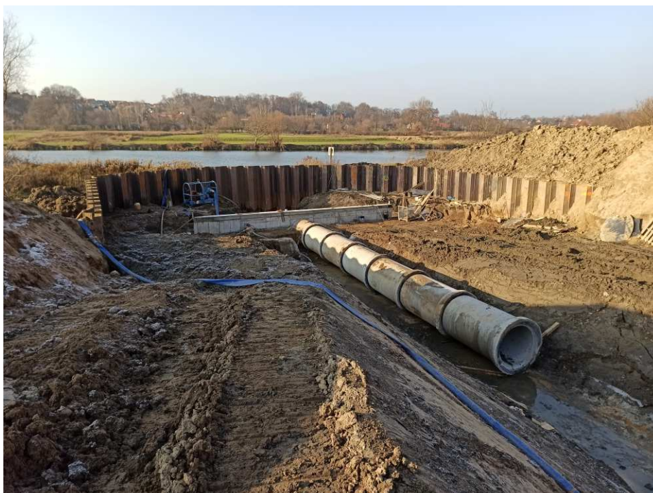
Foto. 26. Przebudowa przepustu wałowego w km 63+115 wału Wisły na Zadaniu 2, stan w trzeciej dekadzie listopada 2020 r. (widok w kierunku międzywału).
