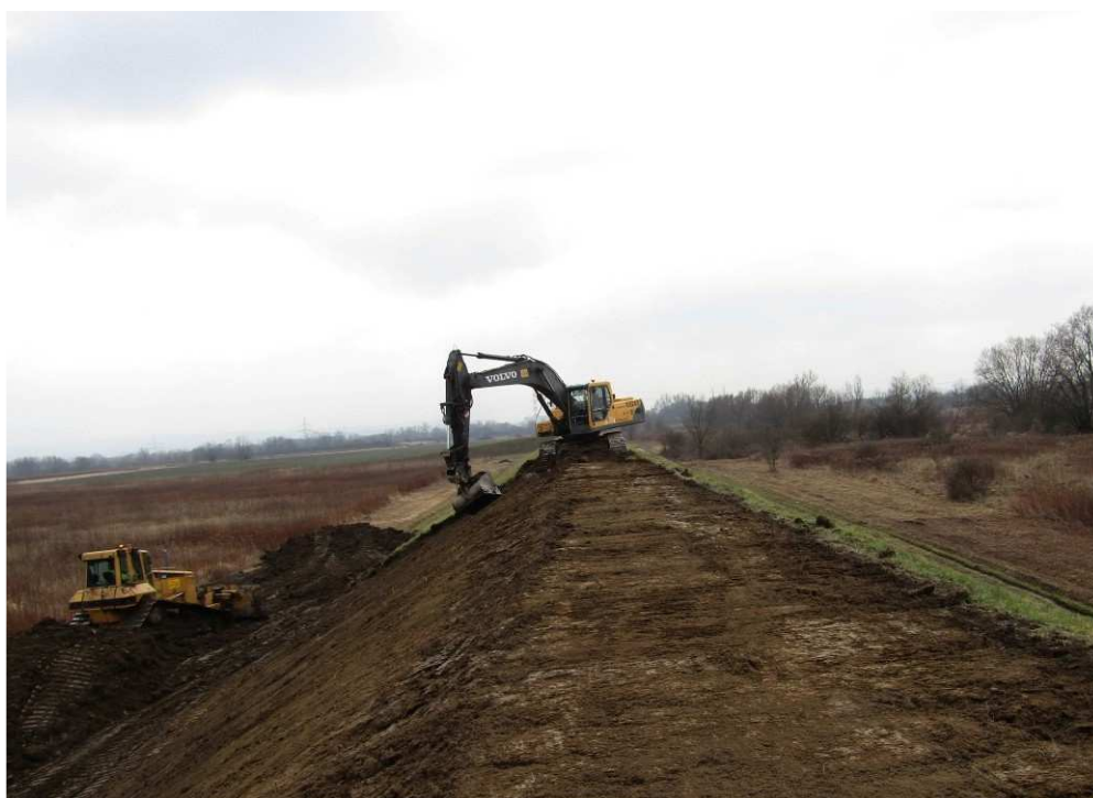
Foto. 21. Zdejmowanie warstwy humusu na Zadaniu 1, stan w trzeciej dekadzie lutego 2020 r. (widok w górę rzeki).
