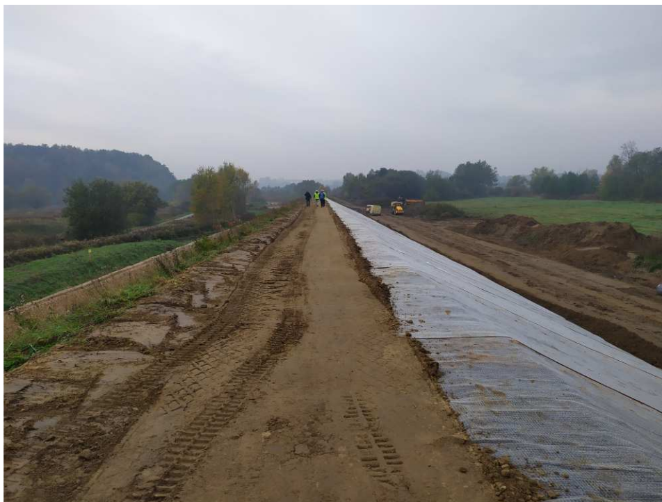
Foto. 33. Układanie bentomaty na skarpie wału przeciwpowodziowego na Zadaniu 3, stan w trzeciej dekadzie października 2020 r. (widok w górę rzeki).
