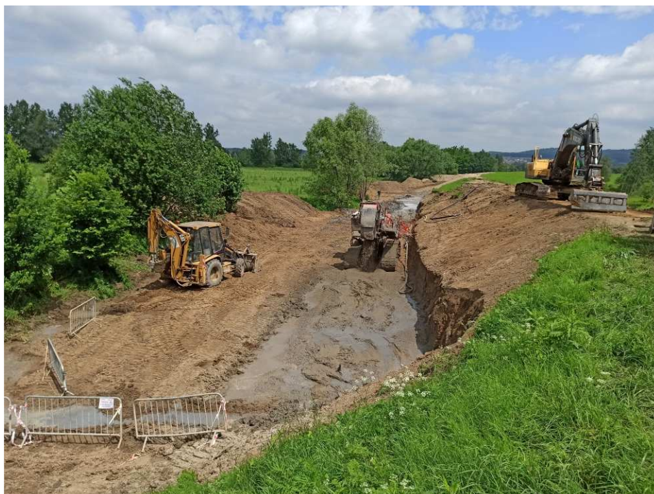
Foto. 30. Budowa przesłony cementowo-bentonitowej na Zadaniu 3, stan w trzeciej dekadzie czerwca 2020 r. (widok w dół rzeki).
