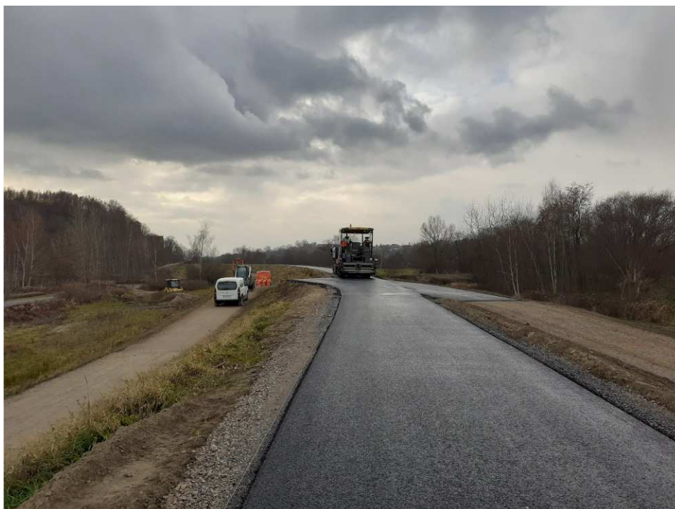
Foto. 38. Budowa drogi na koronie wału przeciwpowodziowego na Zadaniu 3, stan w trzeciej dekadzie listopada 2021 r. (widok w górę rzeki).
