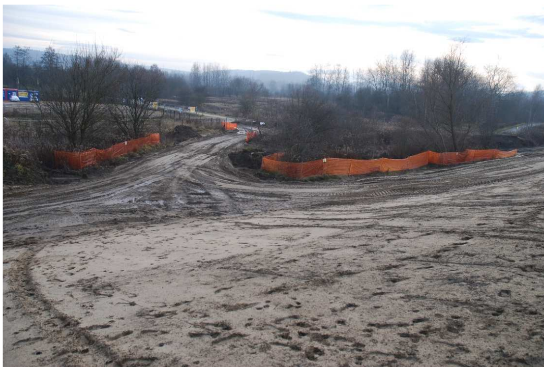
Foto. 20. Zabezpieczenie drzew i krzewów nie planowanych do wycinki na Zadaniu 3, stan w trzeciej dekadzie grudnia 2020 r. (widok w kierunku zawala).
